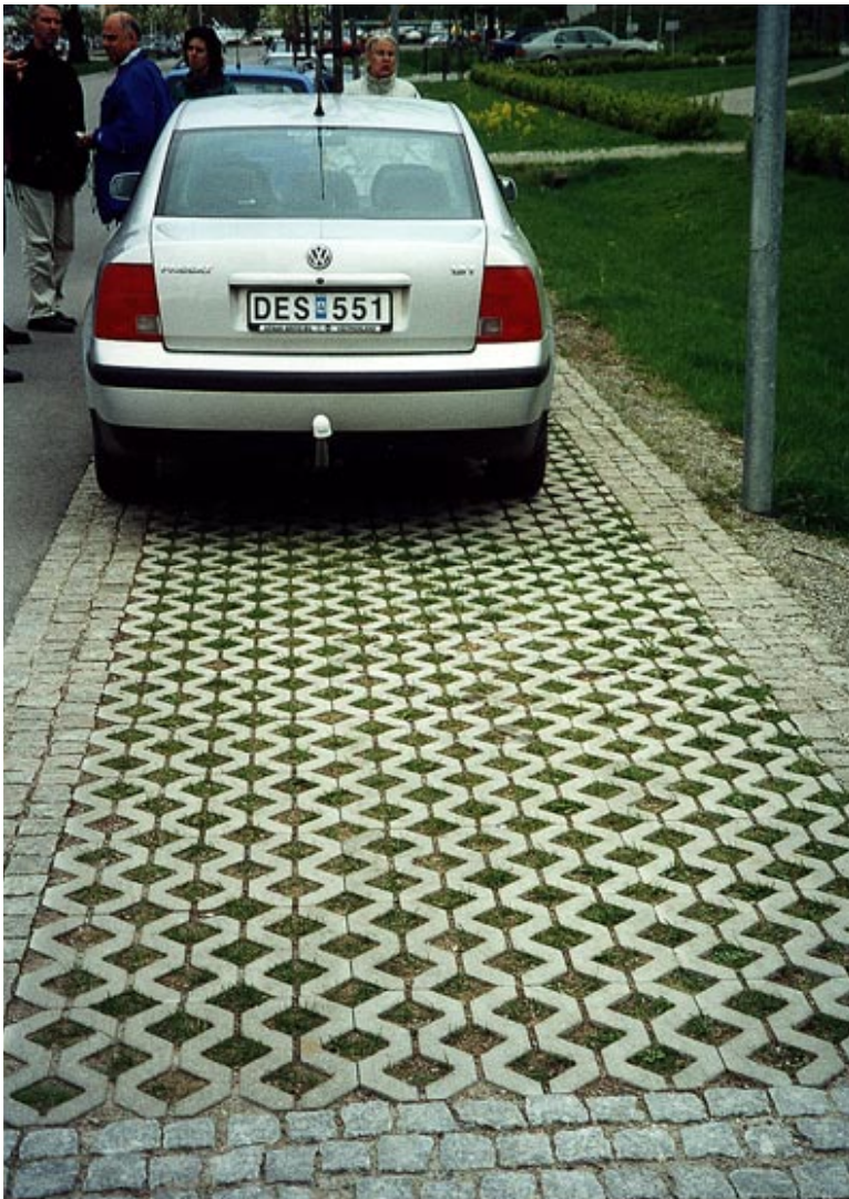
Parkering med betonghålsten
