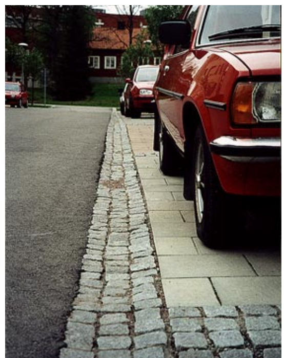
Dagvattenränna med gatsten
