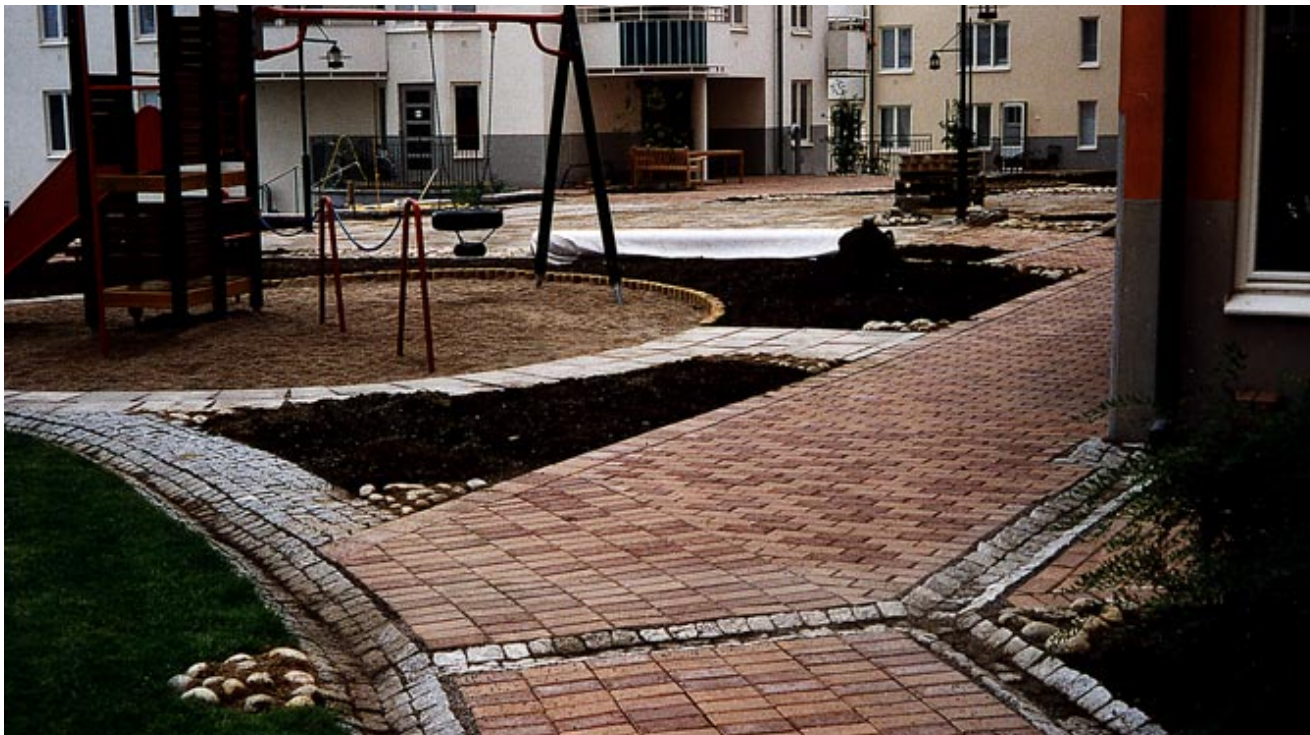
I kvarteret Cigarren får vattnet rinna ut i rännदारar och infiltrera i marken.
