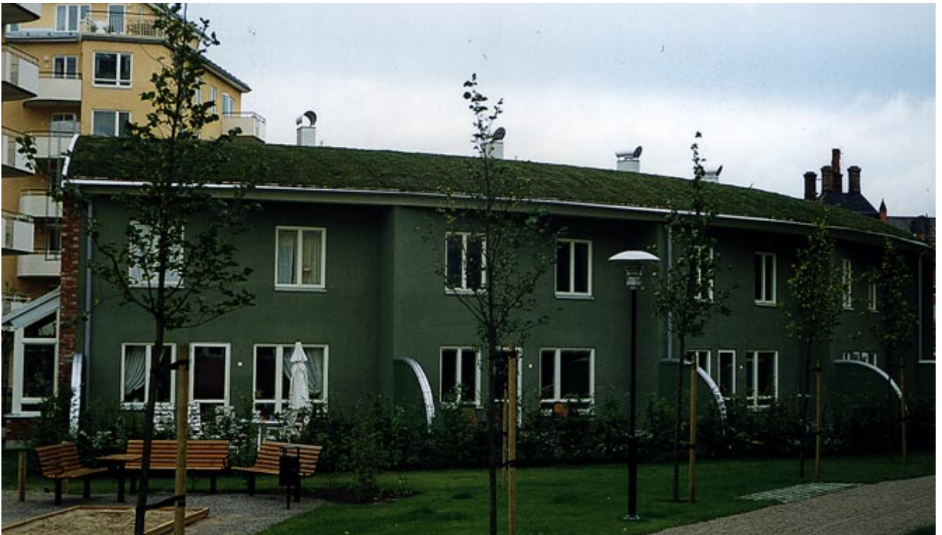
De gröna taken vid kvarteret Kräftan i Kristineberg. 75 procent av nederbörden tas upp av växterna och dunstar bort.
